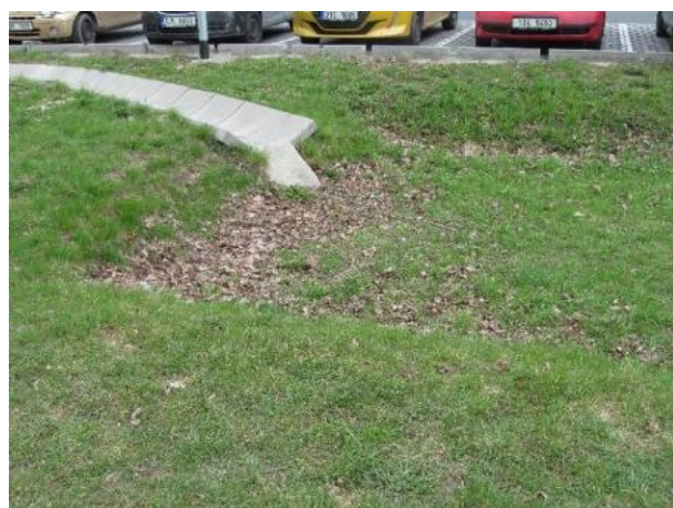
Realizace odtoku srážkové vody z komunikace (Roudnice nad Labem)
