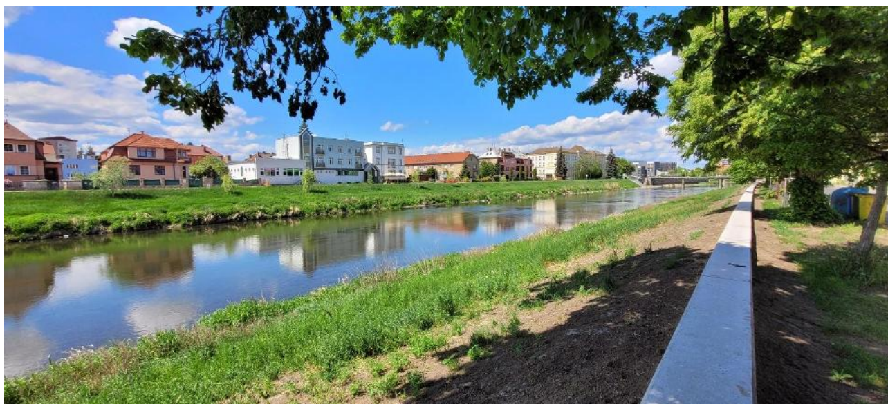
Obr. 41: Ohrázování břehu toku Dyje
