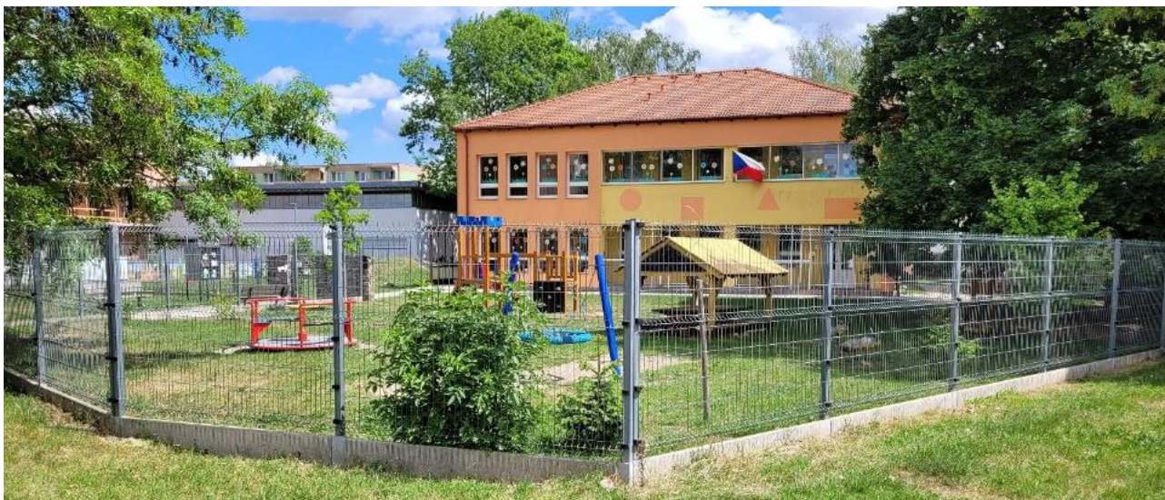
Obr. 45: Areál MŠ Dukelských hrdinů s dostatečným prostorem pro zasakování dešťových srážek.
