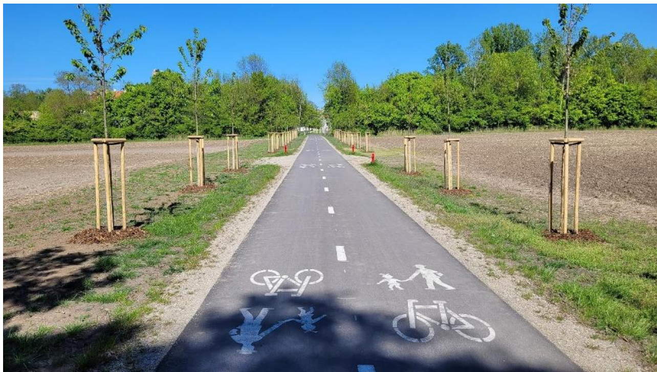
Obr. 54: Ukázková realizace stezky pro cyklisty a pro pěší propojující zastavěné části Břeclavi mimo intenzivní dopravu ve spojení s modrozelenou infrastrukturou.
