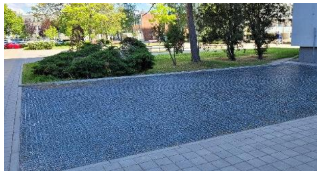
Stání pro vozidla hasičské záchranné služby umožňuje zasakování srážek (Břeclav)
