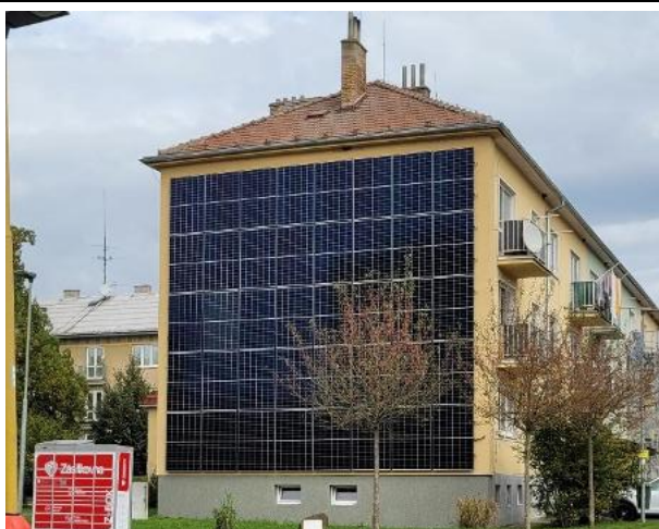
Využití jižní stěny bytového domu pro získání solární energie prostřednictvím OZE (Valašské Klobouky).
