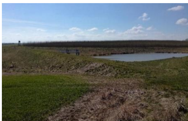
Suchá hráz (nádrž Bravantice) slouží k zadržení srážkových vod z okolního terénu
