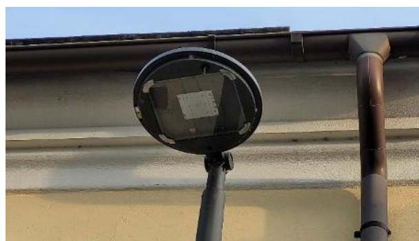
Výměna výbojkových světel za nová se zdrojem LED s regulací světelného toku (Polička).
