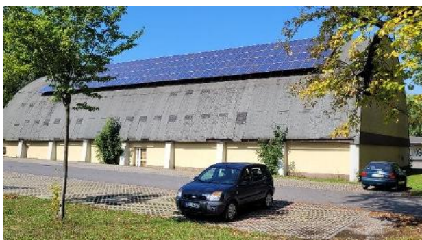
Využití fotovoltaiky pro snížení nákladů na provoz sportovní haly (Český Těšín).
