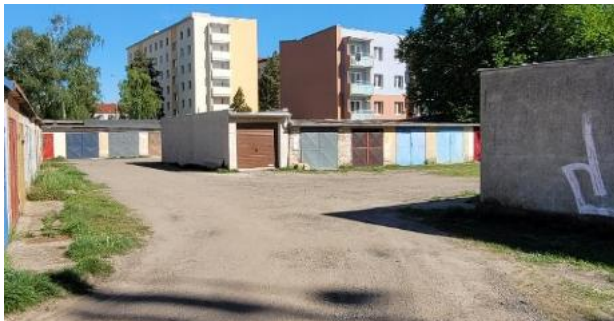
Hromadné garáže v ulici Fintajsova a stejně tak např. v ul. Pyskatého, Na Pěšině, Čs. Armády apod.
