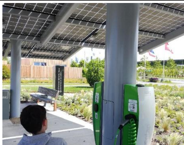
Možný způsob využití solární energie ze střechy veřejné stavby např. pro nabíjení elektrokola apod. (Floriade Nizozemí 2022)
