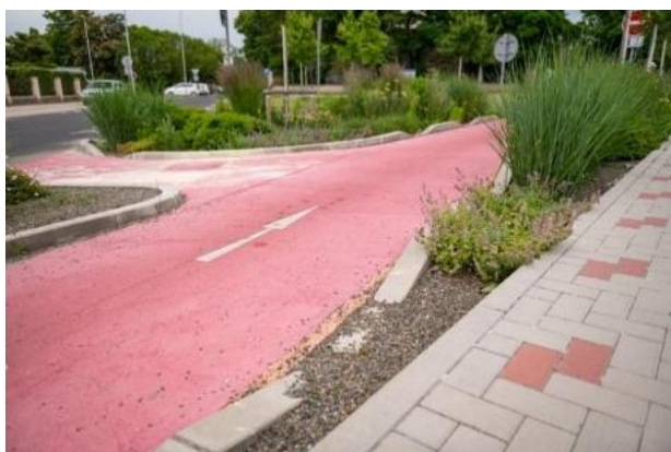
Realizace odtoku srážkové vody z komunikace (Roudnice nad Labem)
