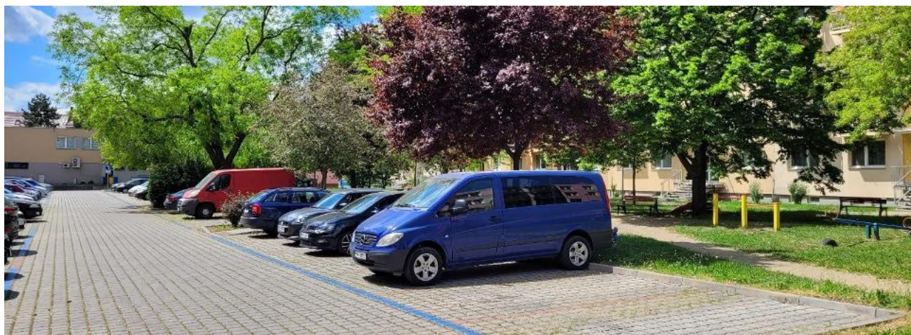
Obr. 42: Polopropustné plochy parkovišť, ul. Slovácká
