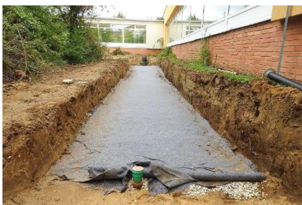
Způsoby zadržování a vsaku dešťových srážek do okolního terénu ze střech budov (ZŠ Uherský Brod)
