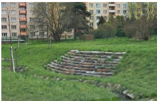
Posedové schody u revitalizovaného toku Kobyliho potoka (Bruntál)
