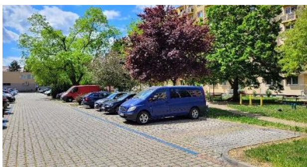
Parkoviště, které umožňuje zasakování srážkových vod, je zadlážděné na širokou spáru (Břeclav)
